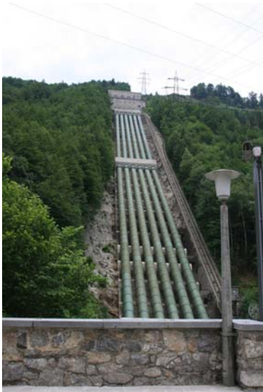
Bild 7: Wasserschloss und Druckrohrleitungen
