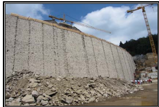
Bild 9: Sanierungsarbeiten an der Stauwand
