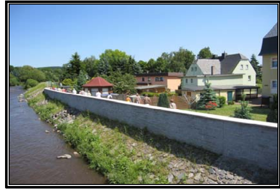
Bild 3: Hochwasserschutz an der Flöha
