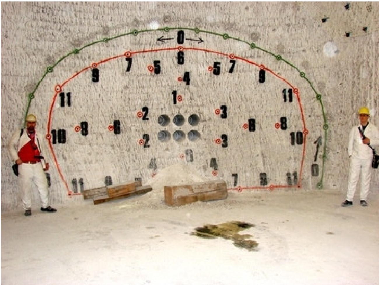
Abb.3 : Musterbeispiel für eine vorbereitete Sprengung
