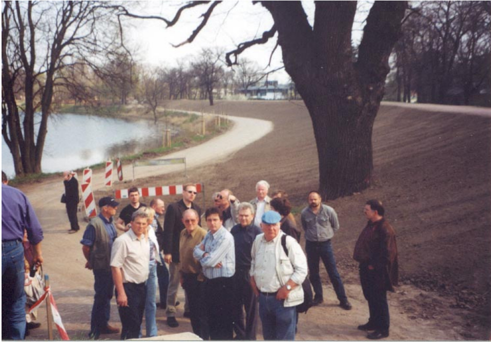
Bild 2: Sanierter Deich Dessau-Stadt
